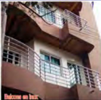
Balcons en inox
