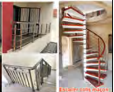
Escalier coïls maçon
