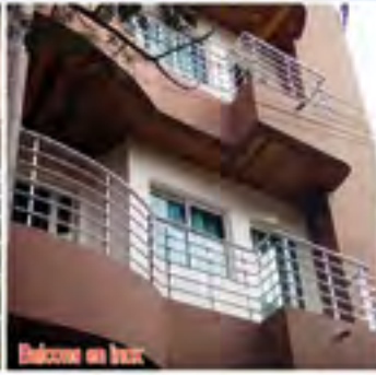
Balcons en inox
