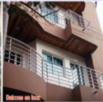
Balcons en inox
