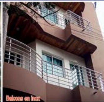
Balcons en inox
