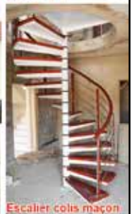
Escalier coils maçonn
